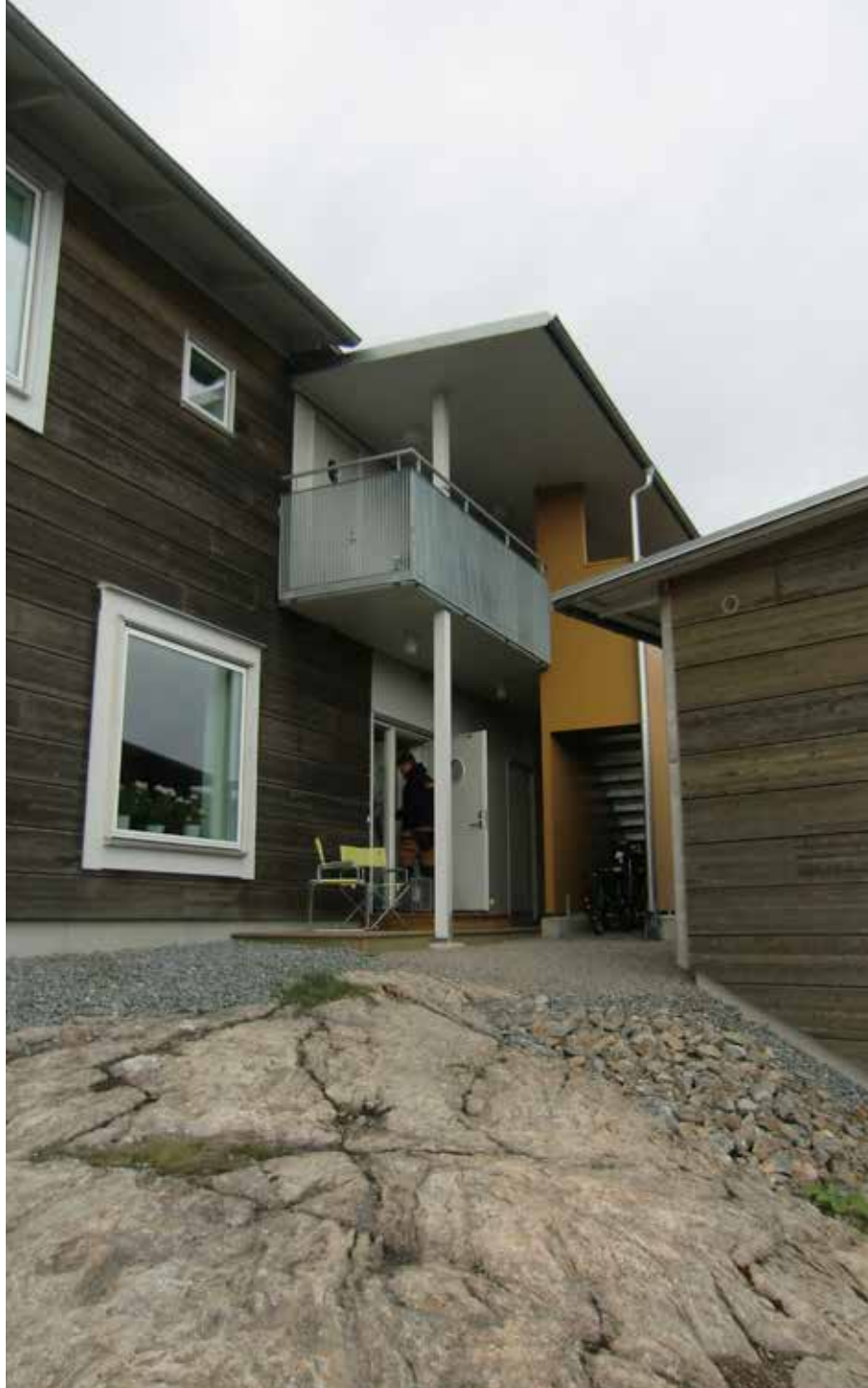
Husen är byggda av massivträ. Foto: David Landström.
